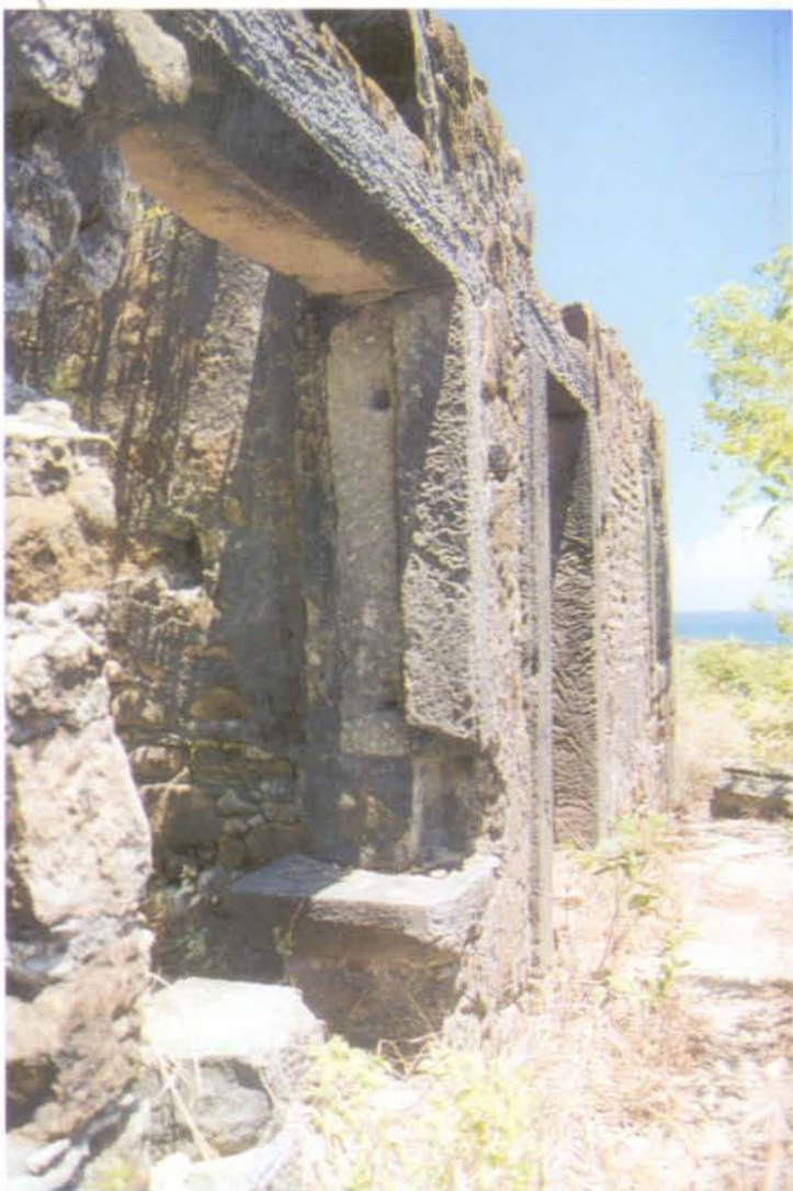
De cantaria eram também as estruturas de 'conversadeiras', um assento de pedra em cada canto da janela, do lado interno
